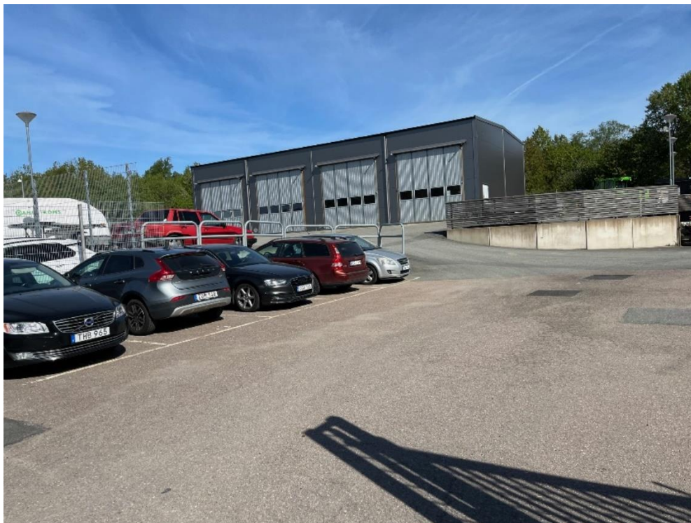
Figur 4-1 Foto tagit mot nordväst vid infarten till den västra delen av fastigheten
